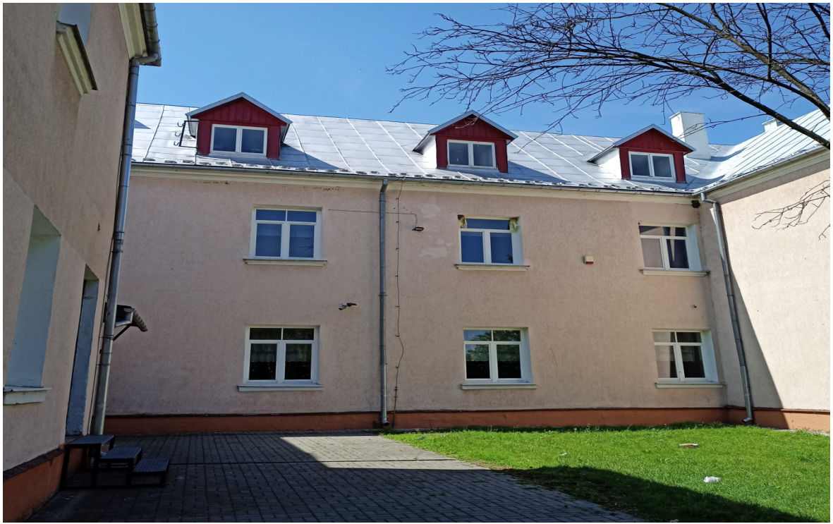
Fot. 5 Widok na elewację wschodnią części środkowej budynku.
