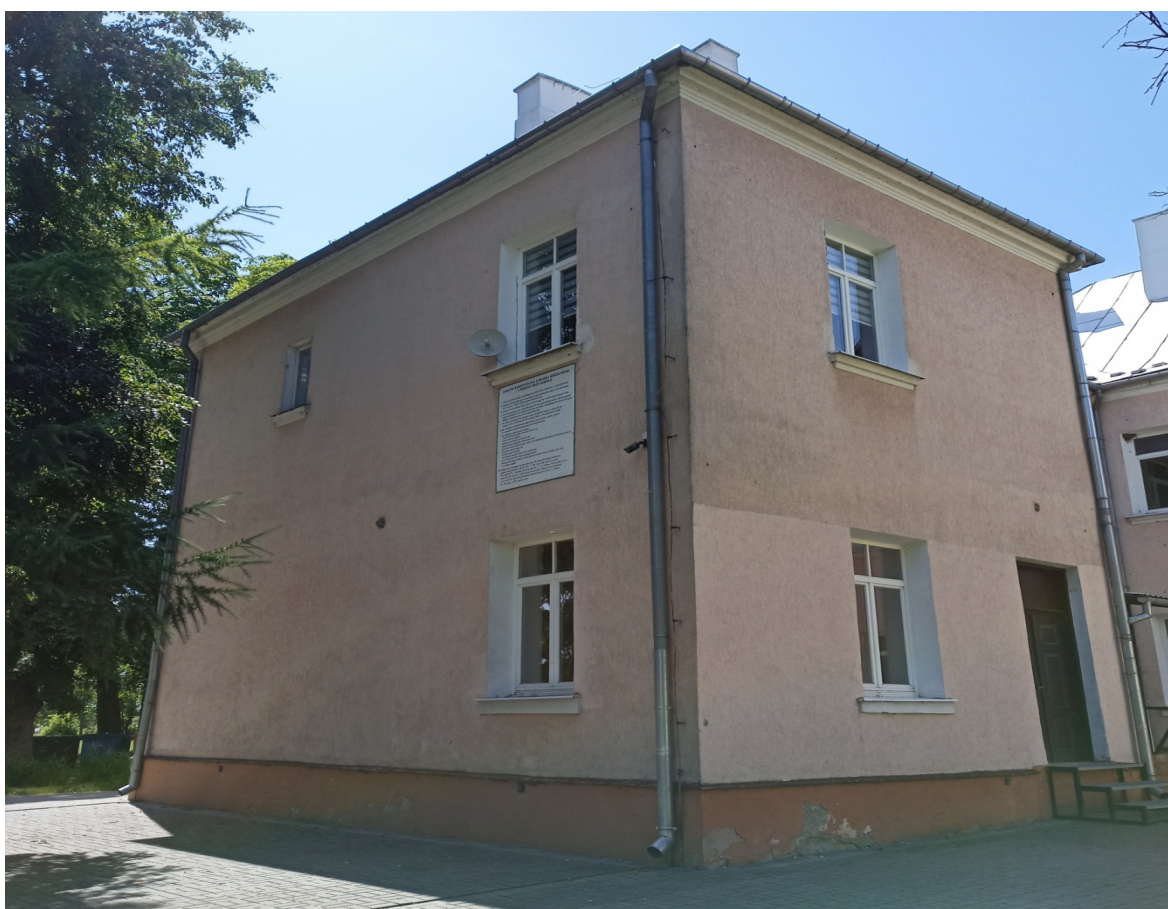
Fot. 4 Widok na elewację wschodnio - północną jednego ze skrzydeł budynku.
