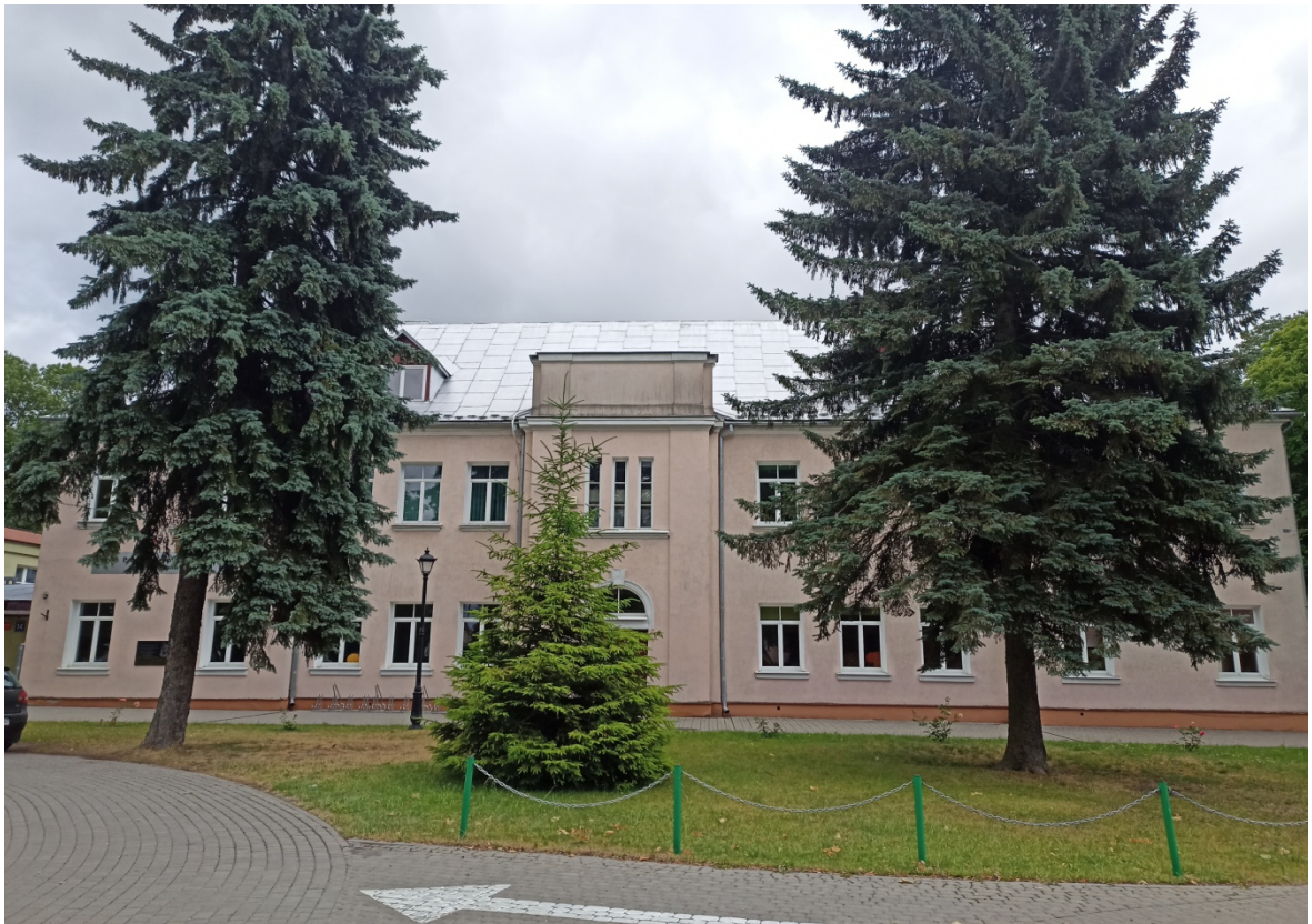
Fot. 1 Widok na elewację główną budynku: zachodnią (od ulicy Chelmskiej).
