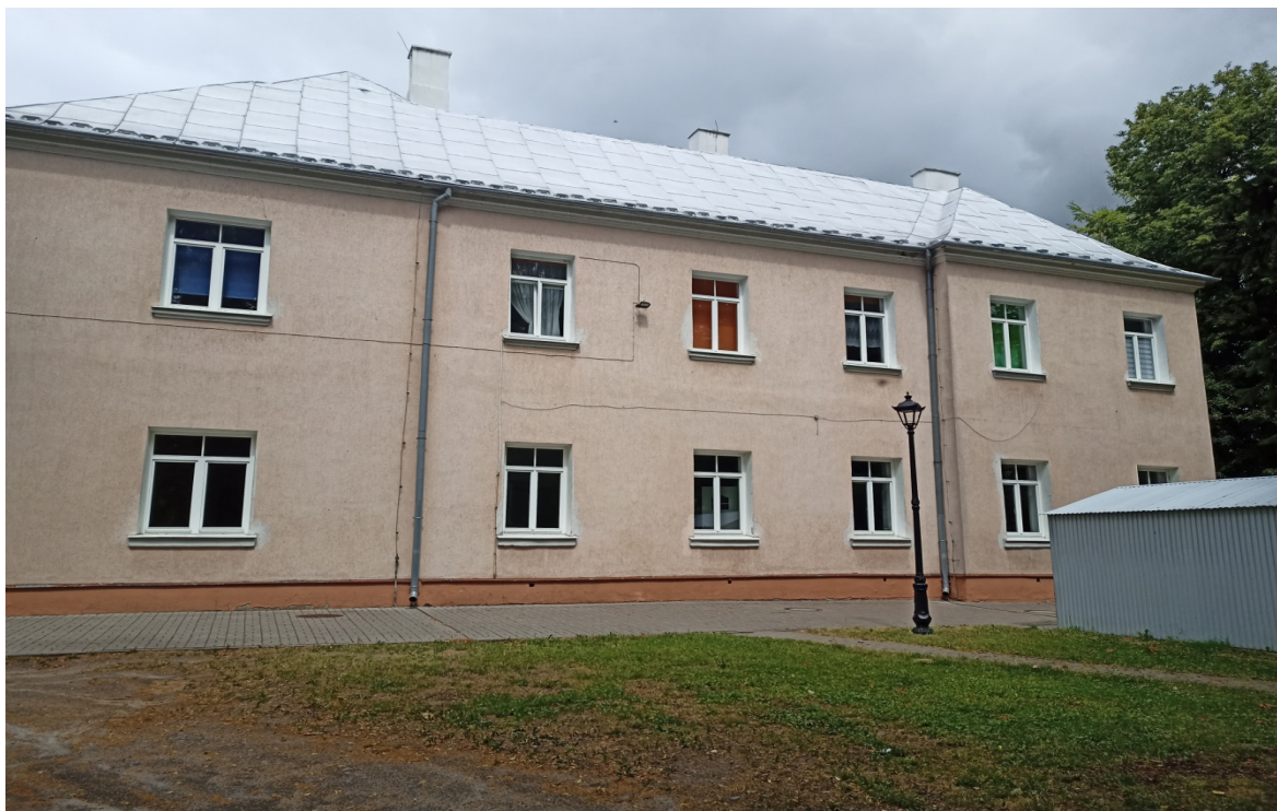
Fot. 3 Widok na elewację od strony południowej.
