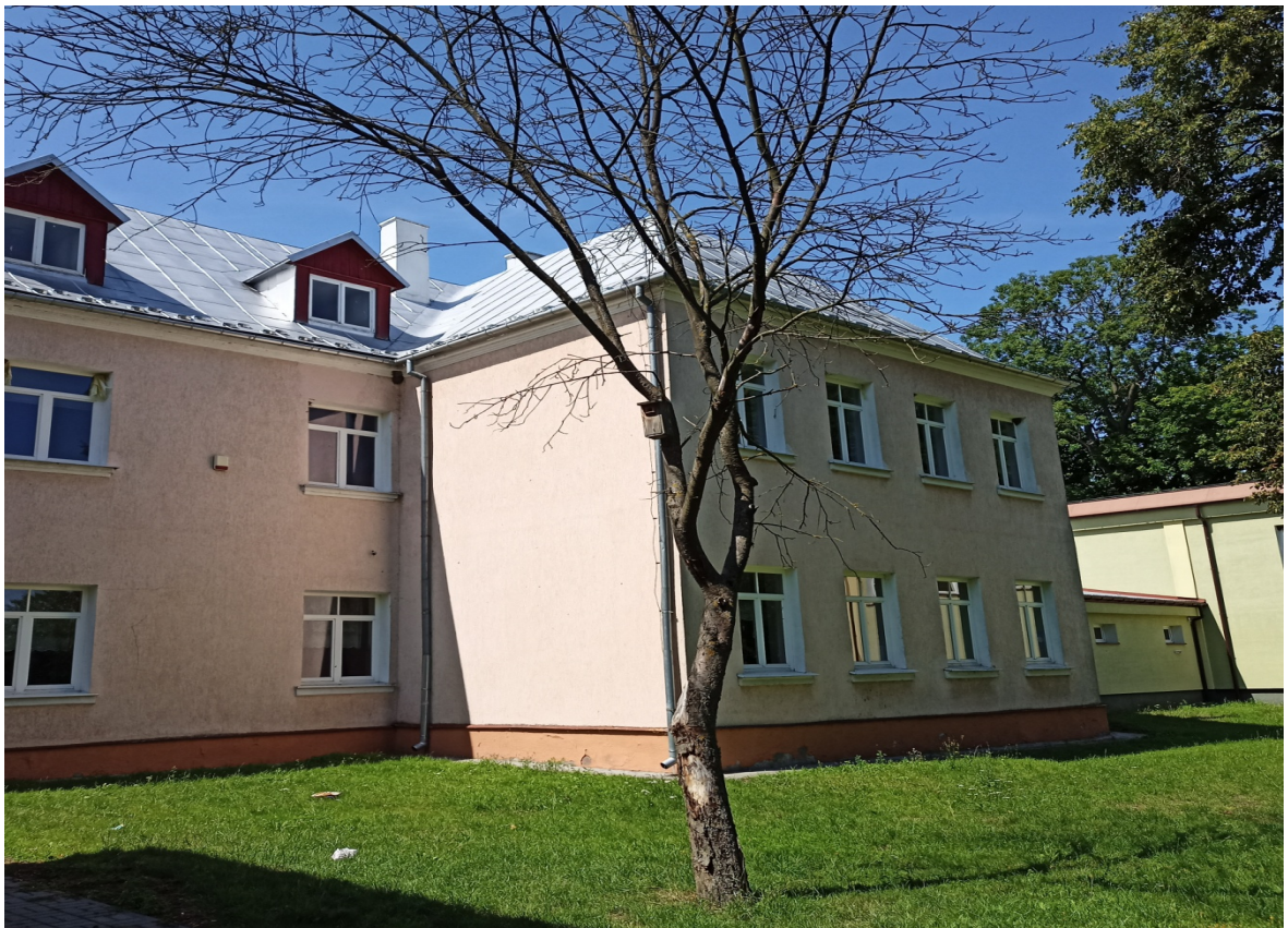
Fot. 6 Widok na elewację od strony wschodniej – jednego ze skrzydeł budynku.
