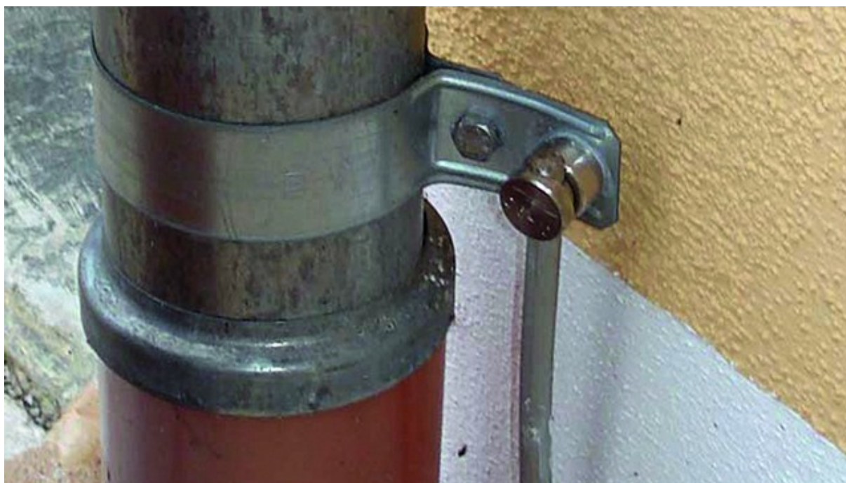
Sposób instalowania obejmy wraz z zaciskiem na rurze spustowej
